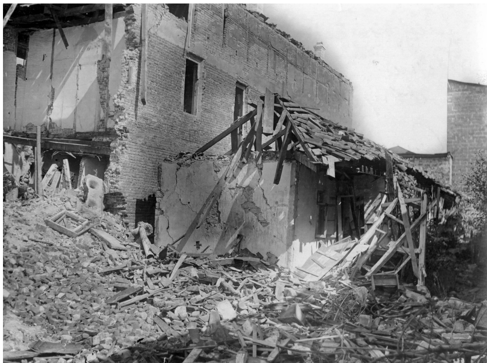
Разрушенный жилой дом по ул. Сталина, 39 (близ кв. доктора Лобанова). Сухум, август 1942 г.
