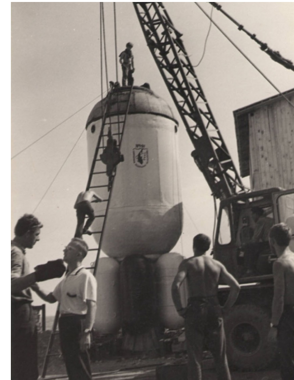
Подготовка к установке подводного дома «Садко» в Черном море, на Сухумском мысе
