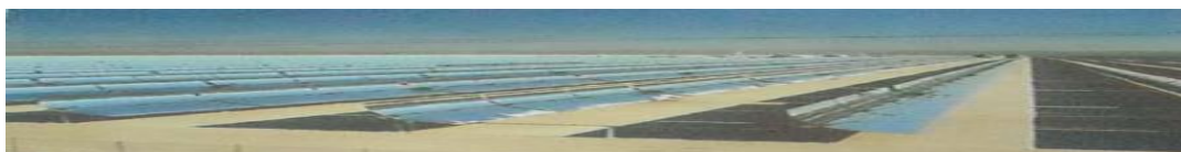
Рисунок 26. ФЭнУ с параболоидно-встроенным концентратором при наличии одноосной системы слежения
