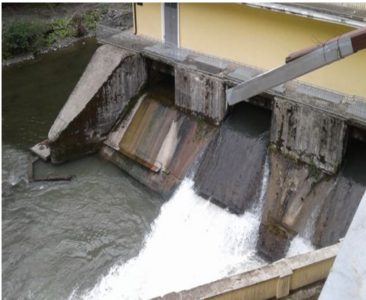
Рисунок 2.12.1. Сброс воды с работающих силовых агрегатов Сухум ГЭС
