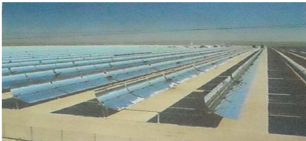
Рисунок 3.3.3. ФЭНУ с параболоидно-встроенным концентратором при наличии одноосной системы слежения
