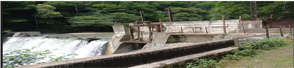
Рисунок 2.11.4. Шлюзовой затвор на Баслат-ЧГЭНМ
