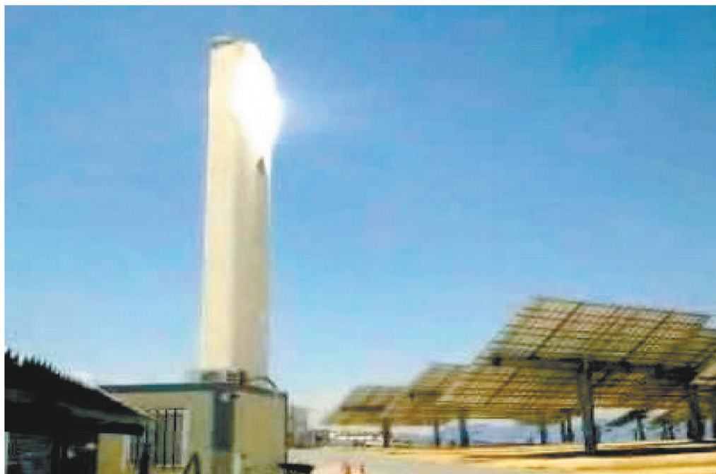
Рисунок 2. СФ-ЭУ с С-ОКУ в виде структурно-башенного концентратора
