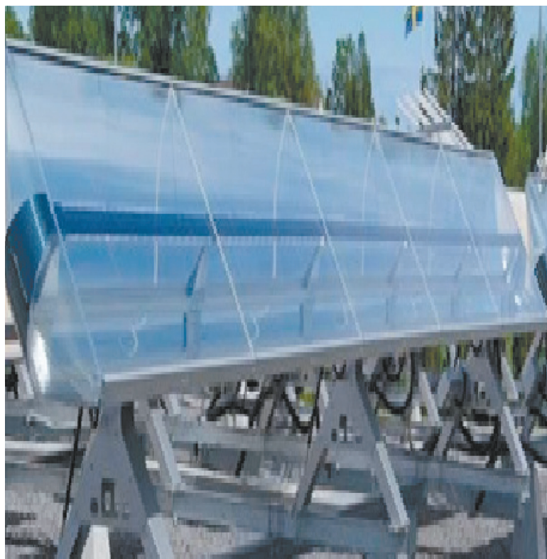
Рисунок 6. Гибридный Ф-ЭнУ, созданный на базе коллекторов С-ЛР и Ф-ЭМ
