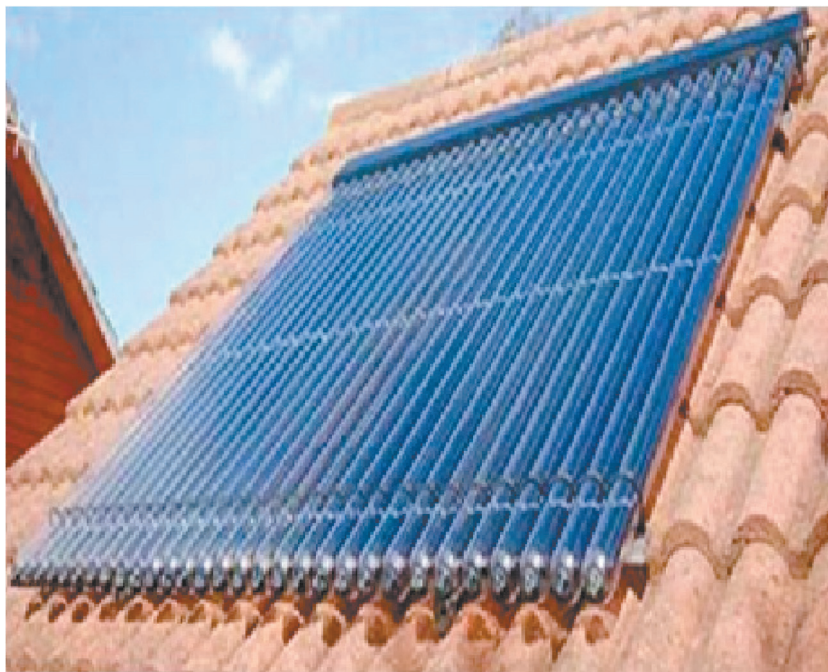
Рисунок 4. Ф-ЭнУ с вакуумными коллекторами С-ЛР
